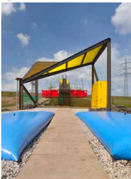
Regenwaterdak en blauwe waterzakken.
