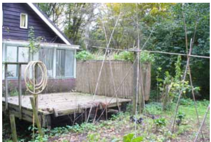
Het te renoveren lichtgewicht helofytenfilter.
