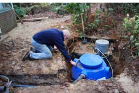
Helofytenfilterbouwer Gerrit Box aan het werk bij de septic tank.
