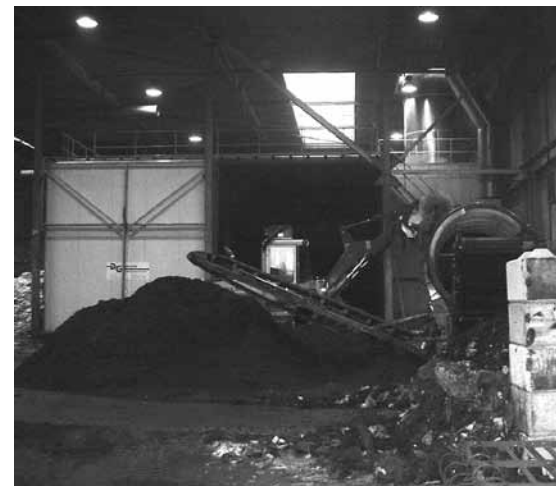
De compostfabriek van Orgaworld in Lelystad, waar ook fecaliën worden verwerkt.
