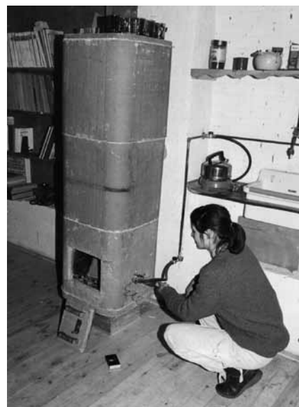
Deze kachel van keramische schoorsteenelementen voorzien van een gasbrander met 'opgesloten gasvlam' werd in 1983 in gebruik genomen. (foto uit ons tijdschrift nr. 30-31 in 1983).
