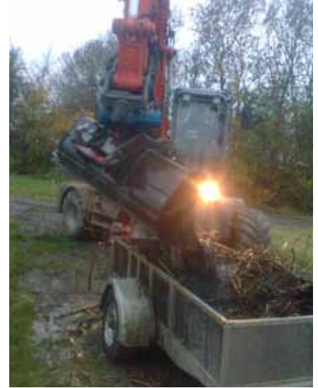
Waterschap Scheldestromen hielp ons met een kraan bij Cadzand aan een volle aanhanger met rietwortels voor het helofytenfilter.
