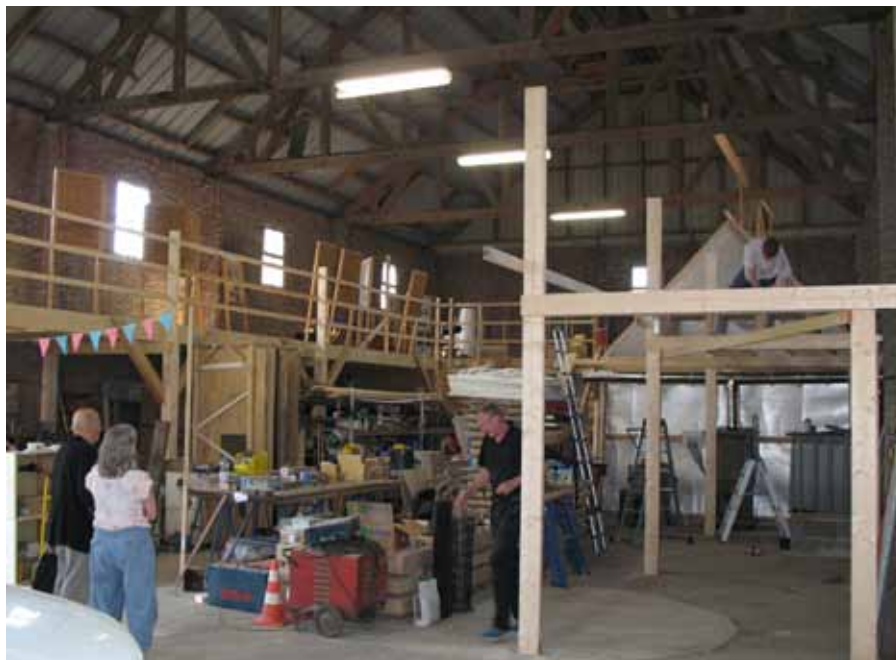
Dirk samen met zijn zoon aan het werk met de opbouw van de balustrade, die inmiddels is voltooid en later met een brug verbonden wordt met de balustrade links.
